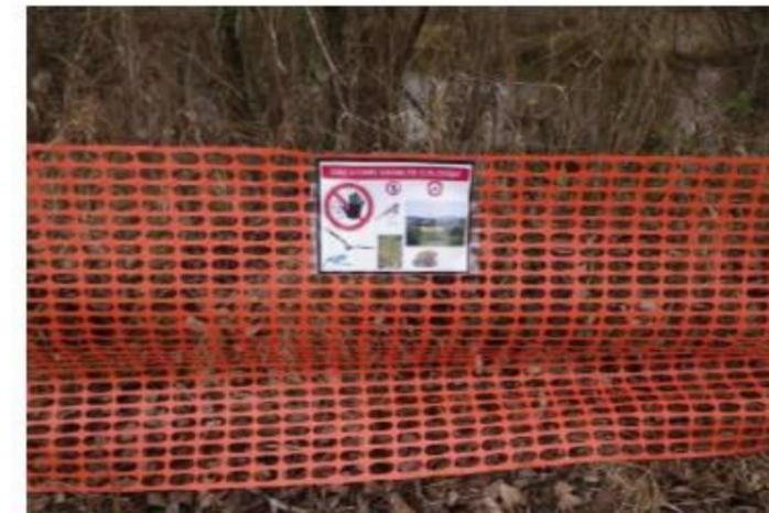
Figure 74 : Différents types de balisages de zones sensibles en bordure des emprises à mettre en place avant les travaux (BIOTOPE)
